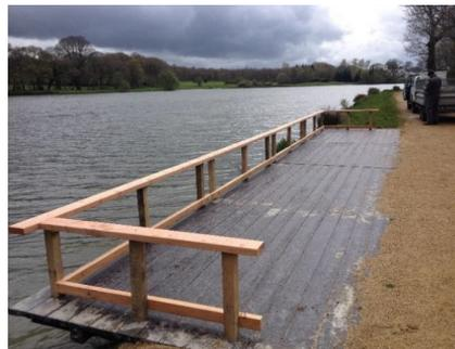
Afin de rendre le parcours accessible pour tous, l'objectif est d'installer deux pontons de 20 mètres environ en rive droite du plan d'eau. L'un à proximité de la buvette et l'autre aux abords de la passerelle en bois. Ces pontons seront composés d'une lisse de 60cm et d'un chasse-roue. Cet
